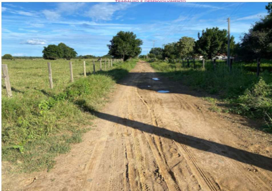
Imagem 13 – Coordenadas: 14°9'50.56"S - 44°13'3.03"W
